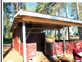
Bildtext: Reparerat vindskydd.
